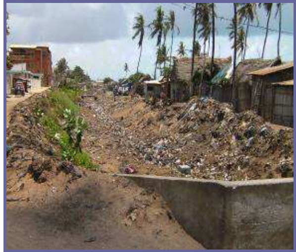
Photo 9: Obstruction du réseau de drainage
