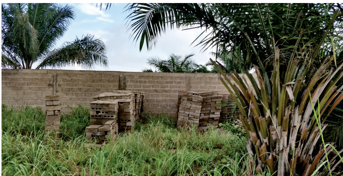
Clôture et parpaings entreposés sur une parcelle en bord de lagune, quartier Togbin © C. Simonneau 2021
