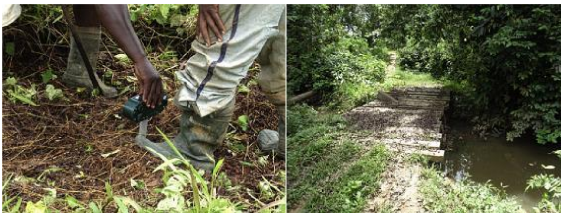
Installation d'un dispositif de diffusion d'ultrasons répulsif à éléphants (à gauche) et pont réalisé pour relier la parcelle à la route (à droite). 20 octobre 2021.
