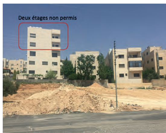
Étages supplémentaires non réglementaires, coopérative de logement, Shafa Badran, Amman © Ababsa 2021
