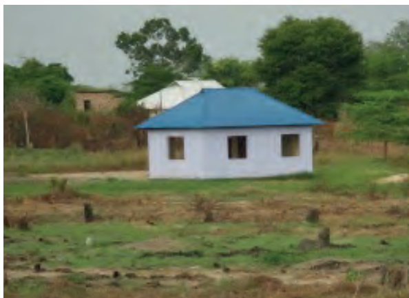
Lotissement à Fukayosi, district de Bagamoyo, Tanzanie © S. Schlimmer, 2018
